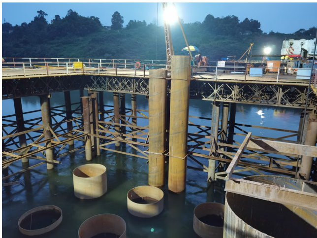
图5 钻孔成槽照片
