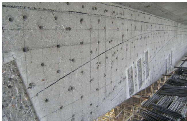
图1 预应力加固法在桥梁中的应用
