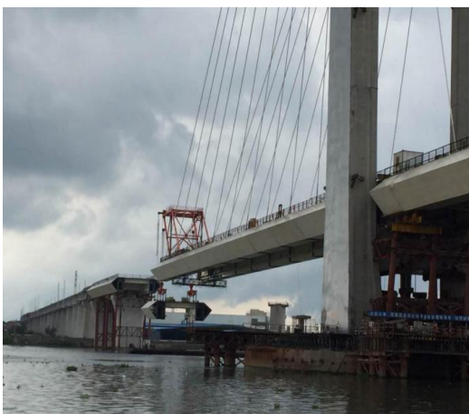
图4.3-2 主跨标准钢箱梁安装
