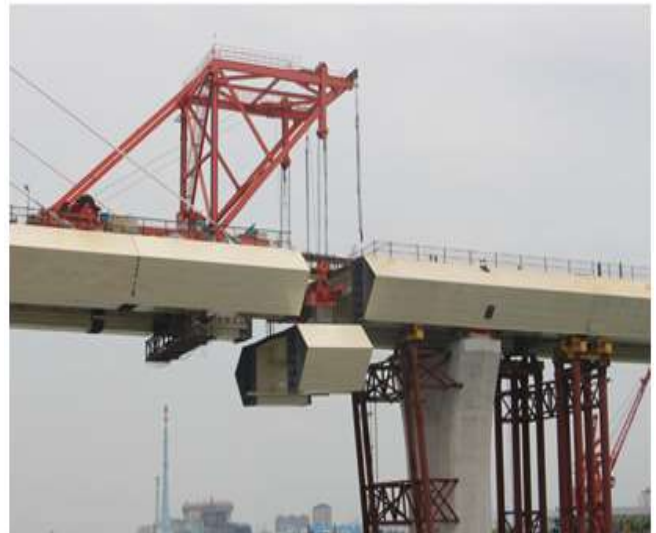
图4.4-1 合龙段施工
