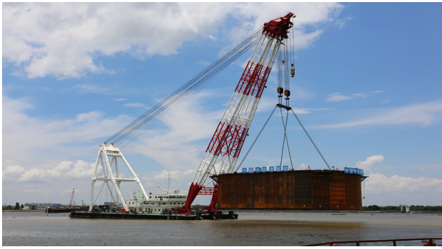
图6 主墩底节围堰绞锚到位
