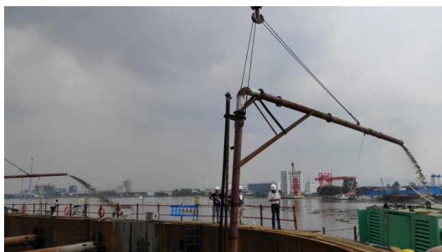
图10 围堰吸泥及挖泥下沉
