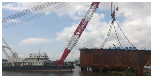
图5 主墩底节围堰起吊
