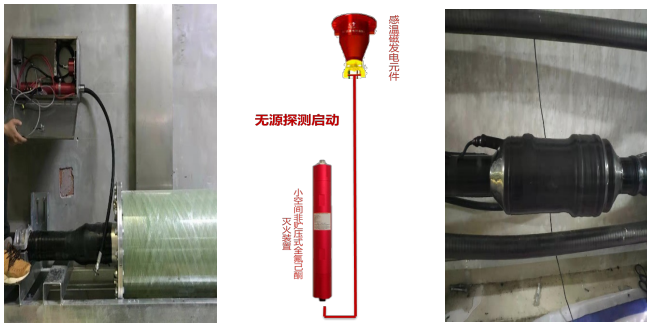
图5 高压电缆接头探测灭火系统设计示意图
