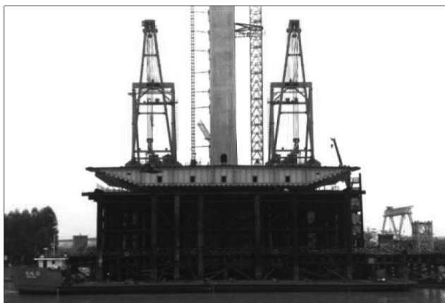
图8 钢混结合段吊装
