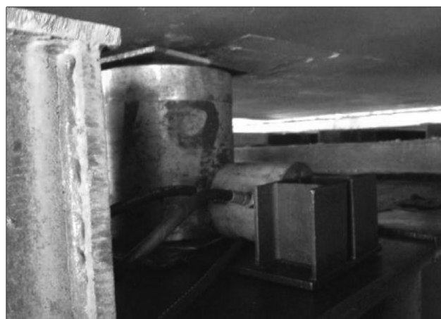
图9 三向千斤顶精确调位
