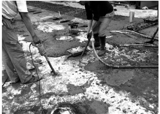
图11 浇筑孔振捣混凝土
