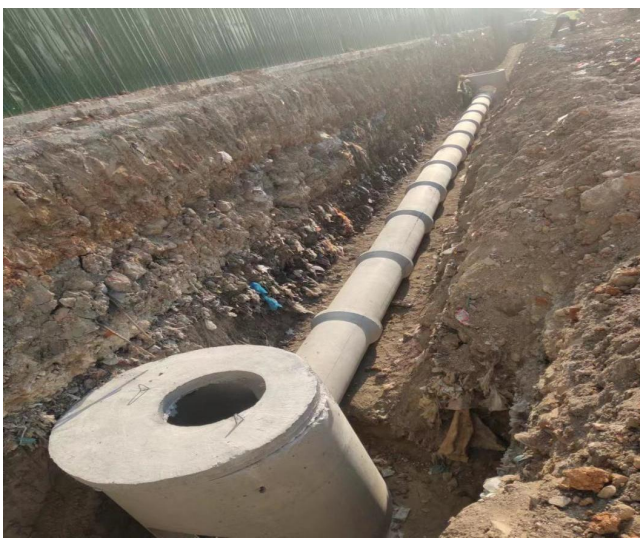
图1 管道下管施工
