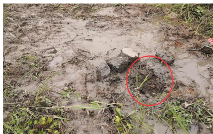
图1 地质钻孔现场图
