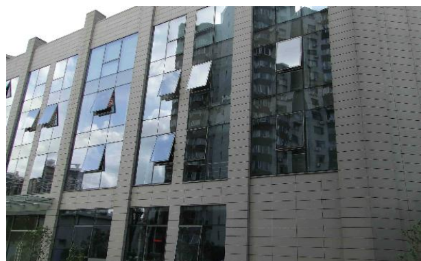
图1-陶土板幕墙整板成果
