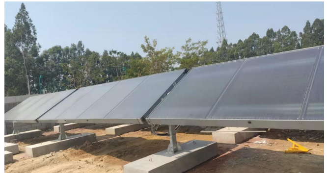
图2 带追踪功能高效太阳能光热系统
