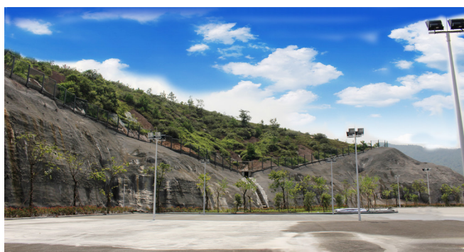
图3:高切坡工程施工效果示意
