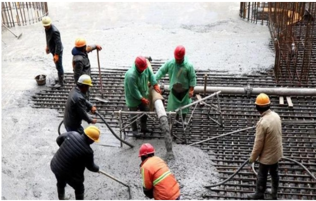
图2 混凝土浇筑现场
