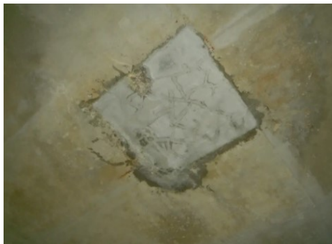
图2 地下室顶板漏水施工后图
