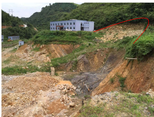
图1 人工切方边坡全景
