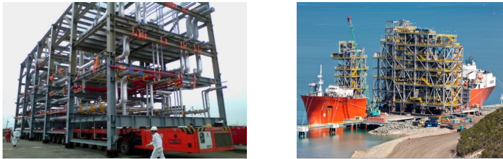
图1 SPMT车运输模块和船运模块
