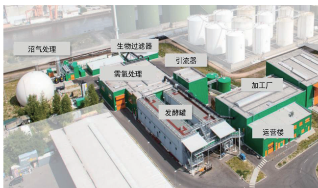
图4 德国柏林乌勒本沼气发酵厂俯视图
