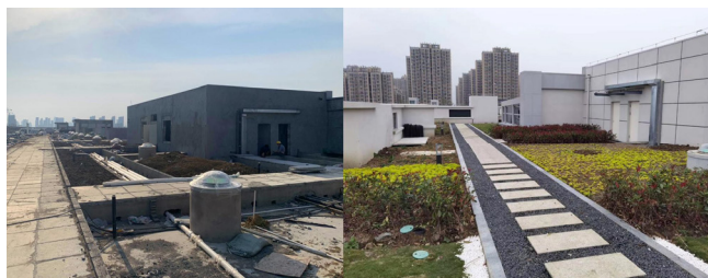
图5 建设中和建成后的实景图
