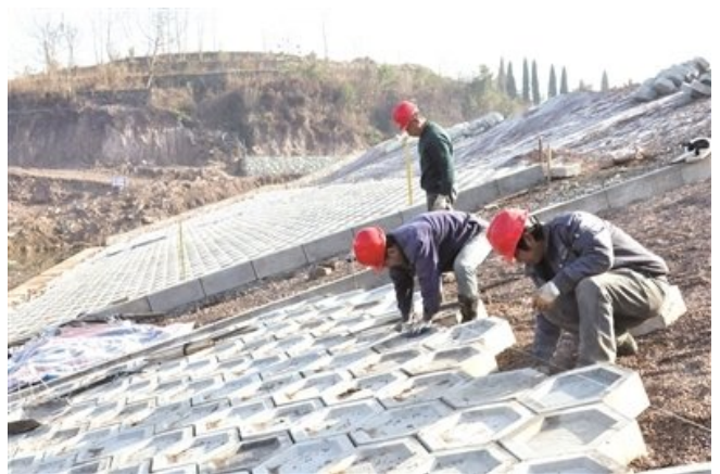
图2 病险水库加固施工作业
