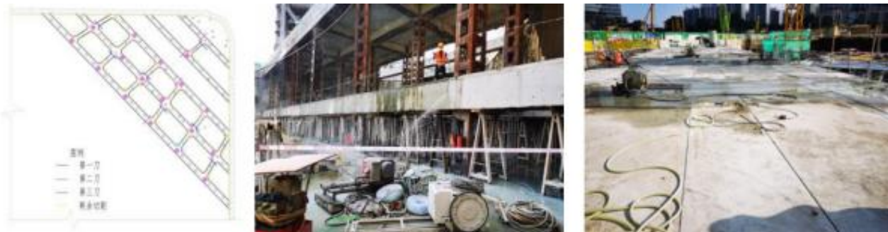
图3 支撑梁板切割安排
