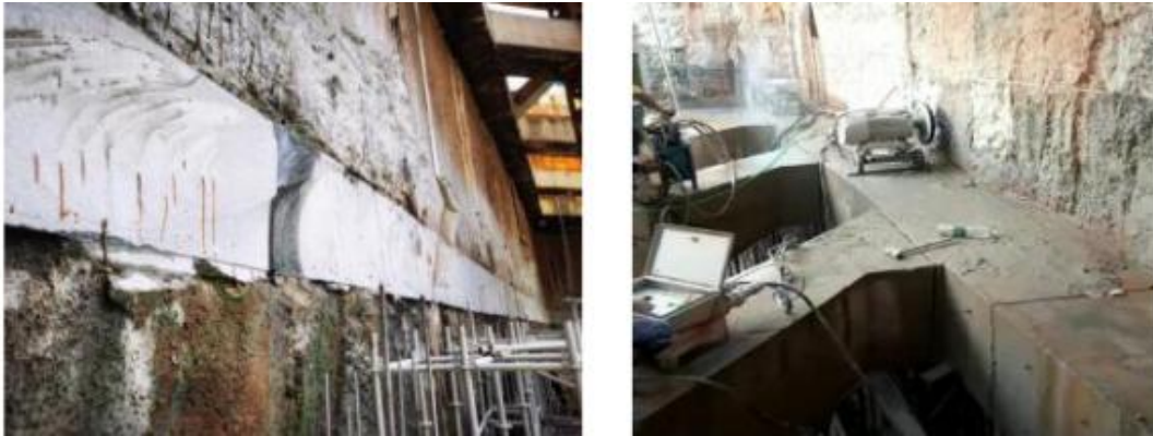
图4 腰梁切割现状图
