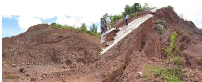
图1 边坡的滑塌
