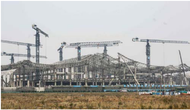
图3 高铁站房主主体钢结构现场图
