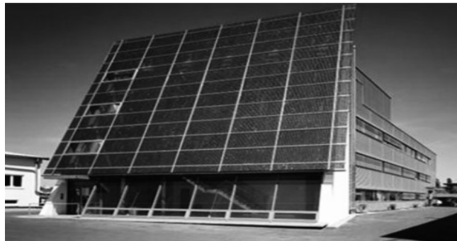
图2 BIPV方式——河北省晶龙“金太阳”光伏建筑一体化
