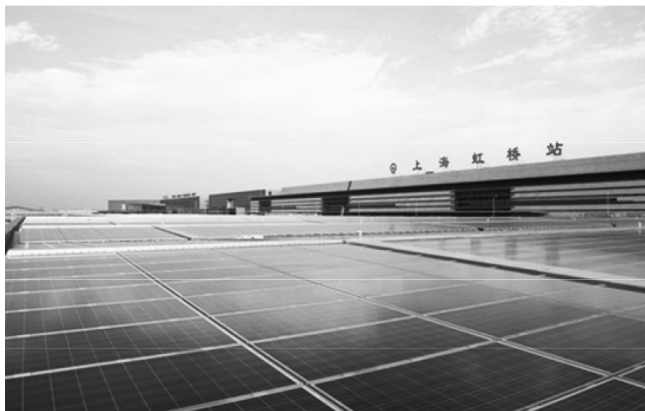
图1 BAPV方式——京沪高铁上海虹桥站屋顶光伏发电
