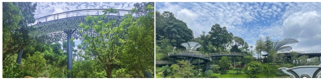
图2 木棉道建设实景
