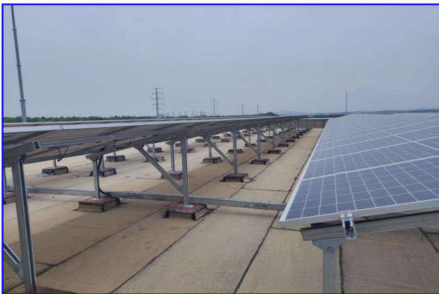
图3 屋面光伏安装完成示意图
