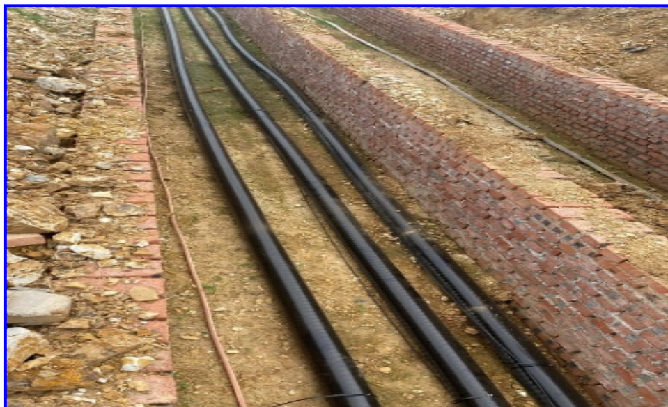
图6 敷设完成的陆缆
