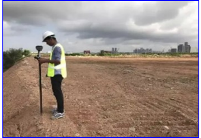
图4 专用测量装置放线图
