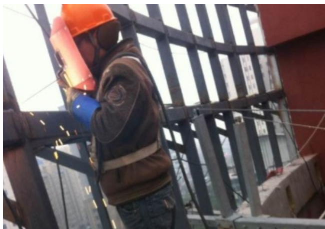
图2 钢结构焊接图
