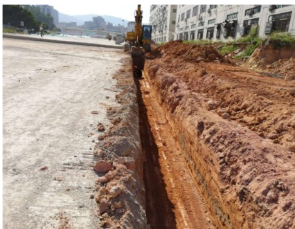
图1 给排水管道的沟槽开挖
