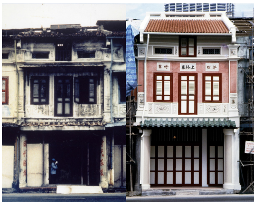
图2 尼道尔9号的平房立面更新前后
