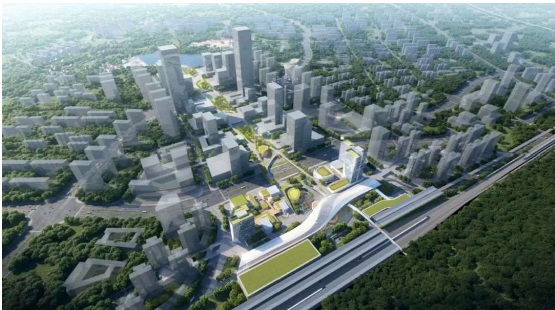
图3 深汕高铁惠州南站枢纽俯拍
