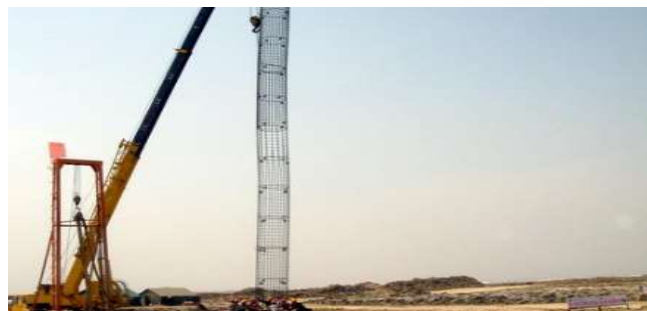
图1 钻孔灌注桩
