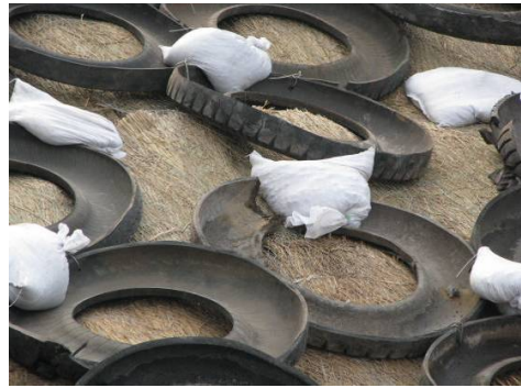
图3 爆破保护覆盖层
