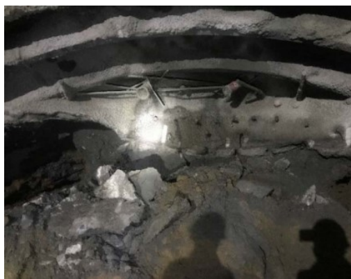
图 1 回填土堆加固处理
