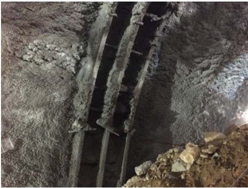
图2 变形初支段护拱施工
