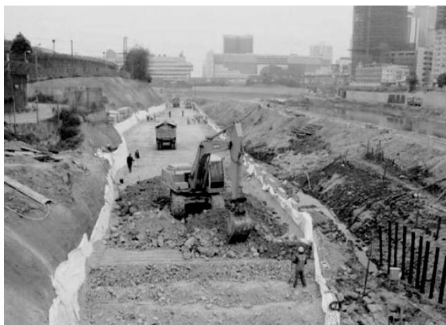
图1 换土垫层法
