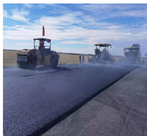
图5 NRP无车辙沥青混合料施工现场
