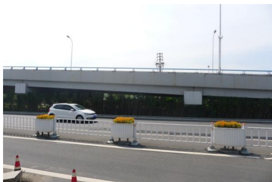
图1 改造前现场图片
