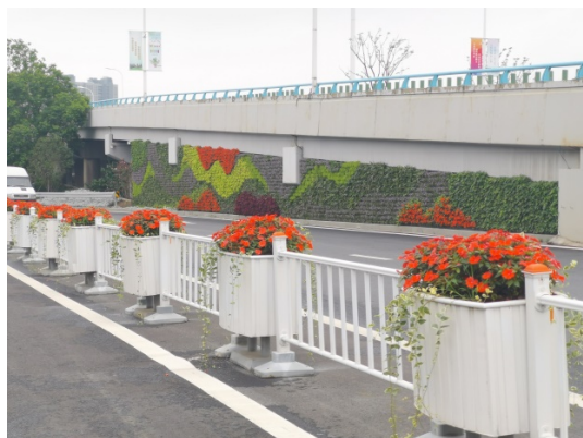
图2 改造后现场图片
