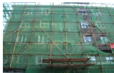
外墙贴保温板
