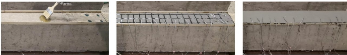
图1-4 BFRP格栅加固混凝土梁
