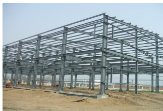
图2-1 装配式钢结构
