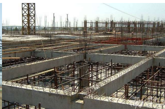
图2-2 装配式混凝土结构
