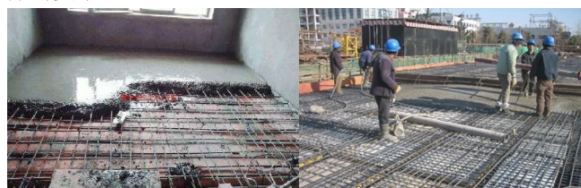
图3-1 钢筋混凝土现浇板
