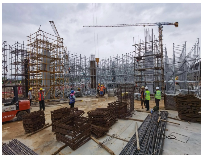
图1 为房建工程项目施工管理现场
