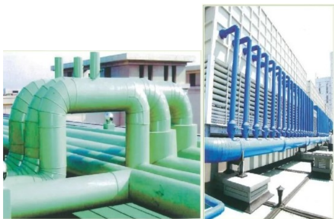
图1 成排管道架空敷设
