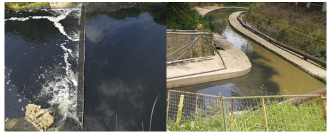
图1 治理前部分河涌现状
