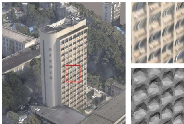
图1 利用倾斜摄影测量方式对某大学教学实验楼的实验结果
