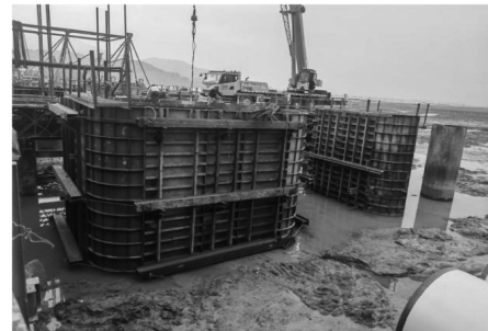
图7 钢围堰安装图
