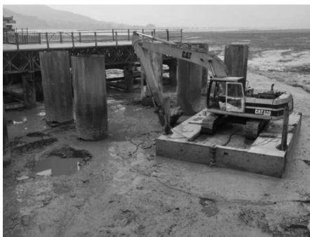
图6 淤泥层开挖图
