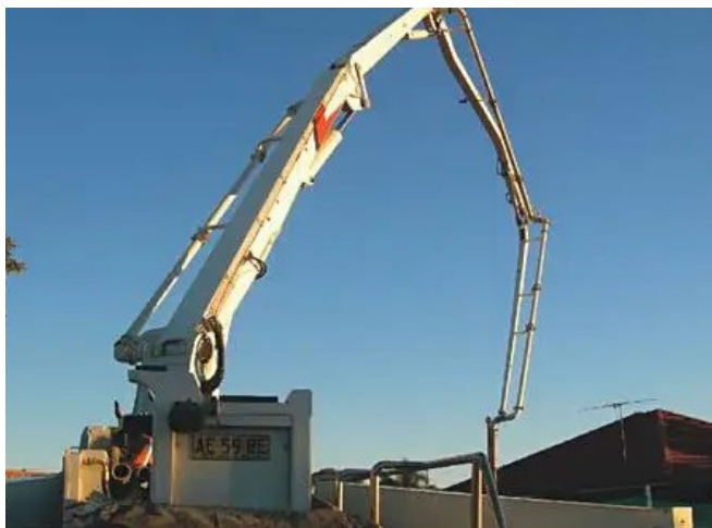
图1 市政工程施工设备
