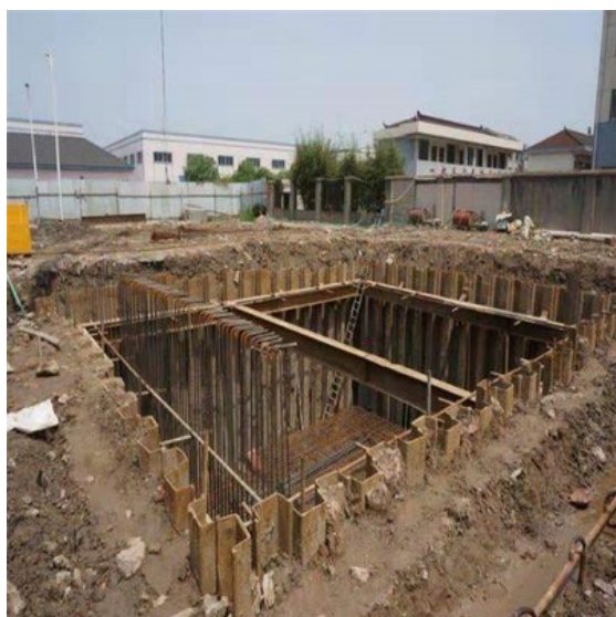
图一 围堰施工
