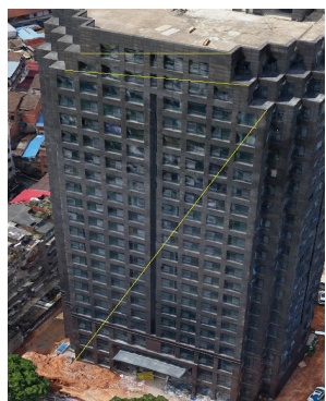
图3 墙体对角线采集
