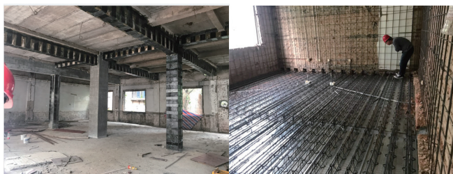
图4.5 梁柱墙及楼板改造加固施工实景图
