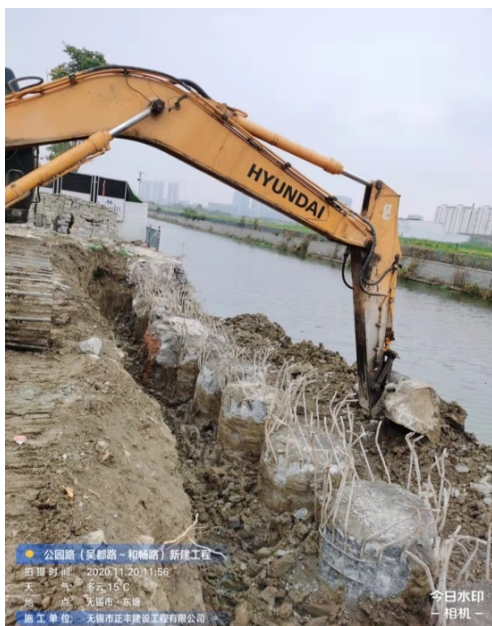
驳岸冠梁凿除照片
