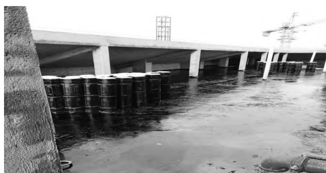
图1 建筑工程防水防渗漏施工
