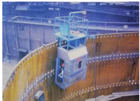
高炉横缝埋弧自动焊接示意图
