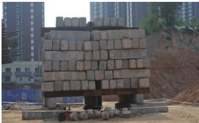
图1 单桩静载检测法
